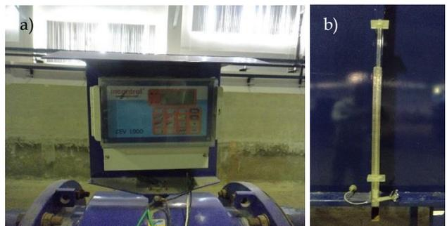
Figura 12. Dispositivo de medição de caudal (a) e piezómetro (b).
