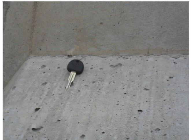
Figura 6. Bolhas na superfície do betão, formadas na interface plana cofragem-betão de um Accropode™.
