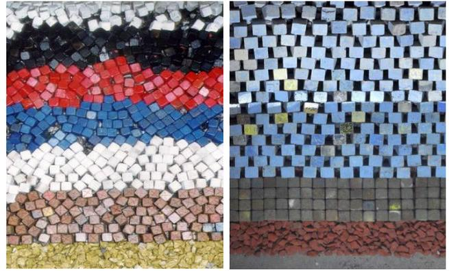
Figura 1. Colocação de Cubos em padrão irregular (esq.) e regular (dir.).
