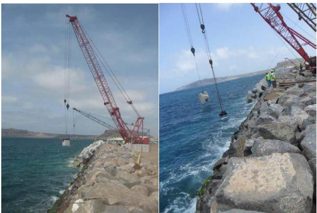
Figura 8. Colocação do Cubo (esquerda) e de Accropode™ (direita).
