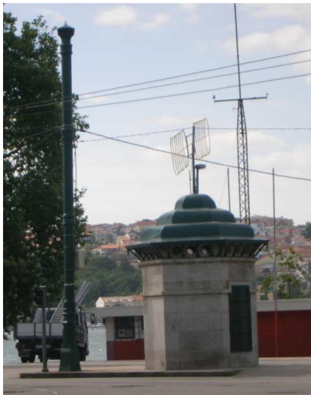
Figura 28. Ejector e torre de ventilação do Lg. António Calém 49
