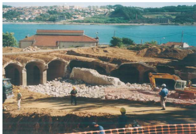
Figura 32. Pormenor do tanque de Sobreiras 56 .
