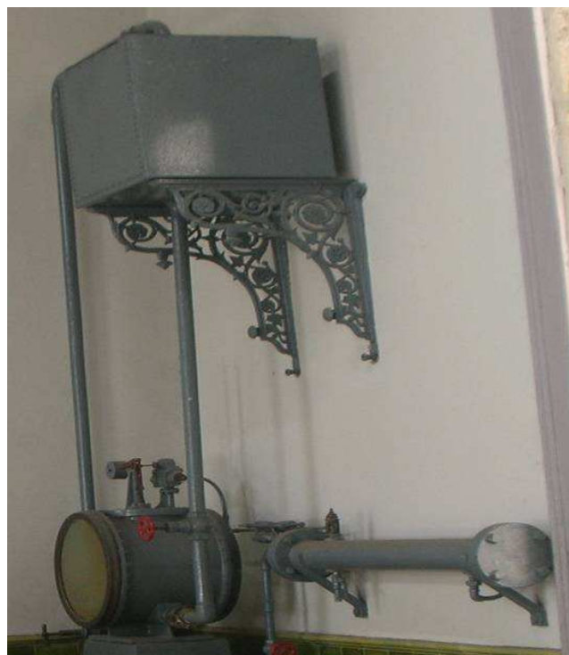
Figura 26. Ejector shone dotado de superfície envidraçada.
