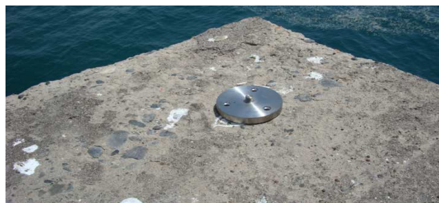
Figura 3. Marcas físicas utilizadas na materialização dos pontos de controlo pertencentes às redes de monitorização, controlo de estabilidade absoluta do quebramar e atracação.
