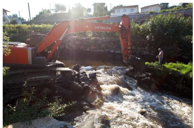
Figura 2. Demolição do açude dos Moinhos do Lopes Mudo .
