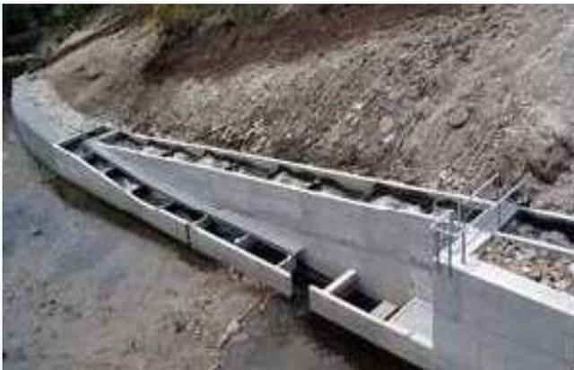
Figura 4. Passagem para peixes da barragem de Canedo, por onde são descarregados os caudais ecológicos, Aqualogus.
