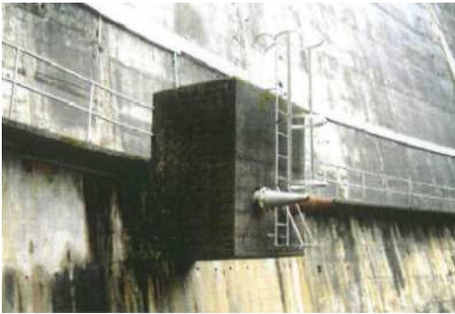
Figura 2. Dispositivo de caudal ecológico (*bypass* na descarga de fundo) da barragem de Vilarinho das Furnas, EDP - Gestão da Produção de Energia, S.A. (2006b).
