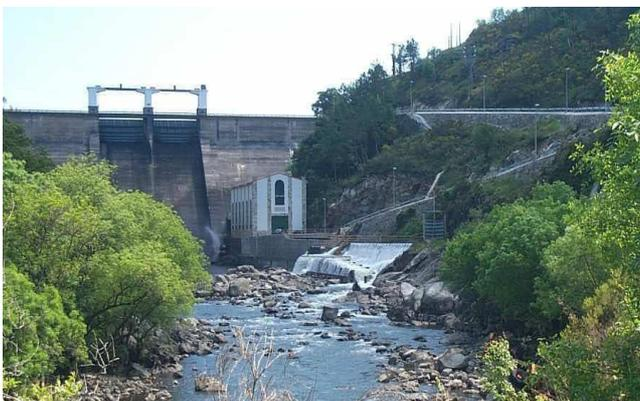
Figura 5. Mini-hídrica da barragem de Barrié de la Maza, através da qual são descarregados os caudais ecológicos, Ministerio de Medio Ambiente y Medio Rural y Marino (2010).
