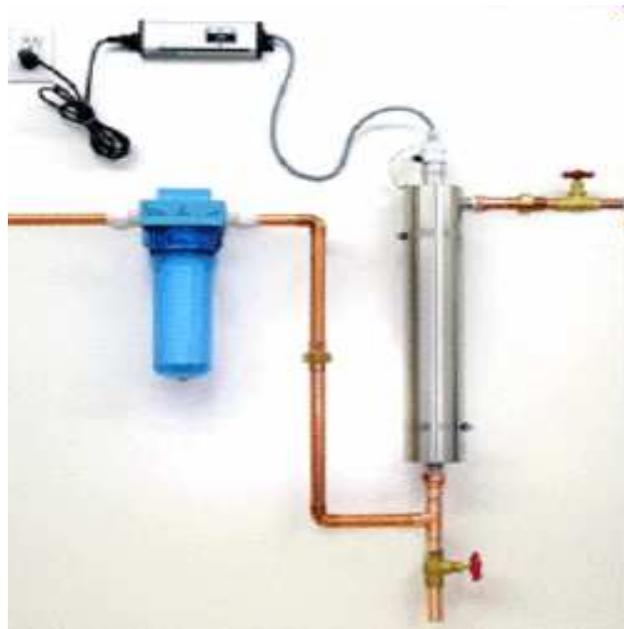
Figura 9. Lâmpada UV para 19L/min.
