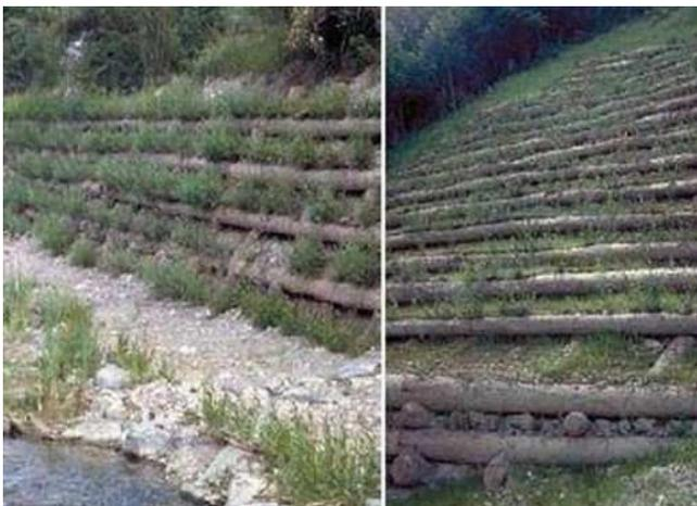
Figura 15. Aspecto final de um talude protegido com troncos de madeira com interposição de estacaria viva.
