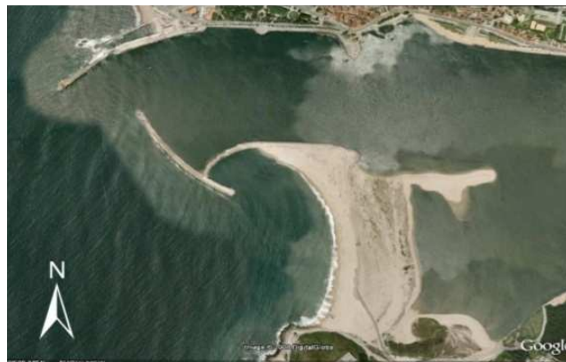
Figura 2. Fotografia aérea da barra do Douro durante a construção dos quebramares. Google Earth, 2008.
