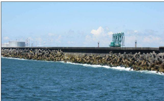
Figura 1. Pormenor do manto de tetrápodes do quebramar Norte do Porto de Leixões, na secção do Posto A (3 de Junho de 2008).
