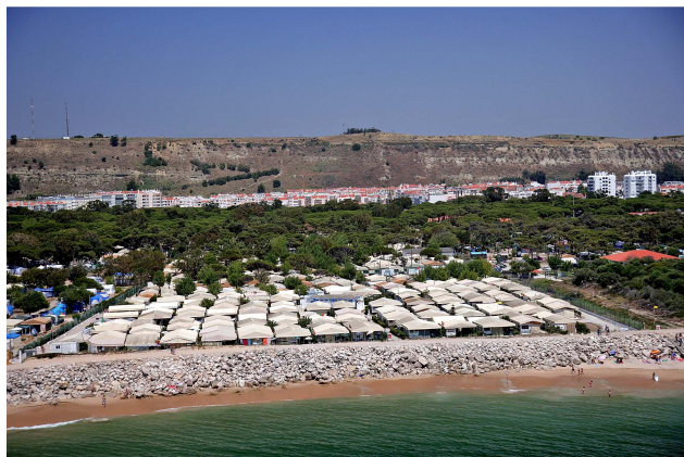
Figura 6. Um dos parques de campismo na praia de S. João em Junho de 2006 protegido pela referida obra de defesa aderente precária, reperfilada em 2007. Ao fundo a arribá fósil. Para quando a desocupação de uma faixa de segurança?
