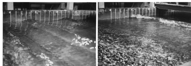
Figura 14. Onda progressiva (esquerda) e sua rebentação parcial (direita) [de um relatório entregue em Maio de 1965].
