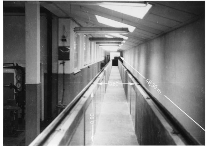
Figura 2. Canal hidráulico em betão nas instalações da Rua dos Bragas (Perspectiva 2 na Figura 1).
