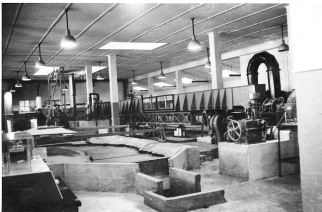
Figura 3. Turbina *Francis*, freio de *Prony* e regulador, e tanque para modelos reduzidos 3D (Perspectiva 3 na Figura 1).
