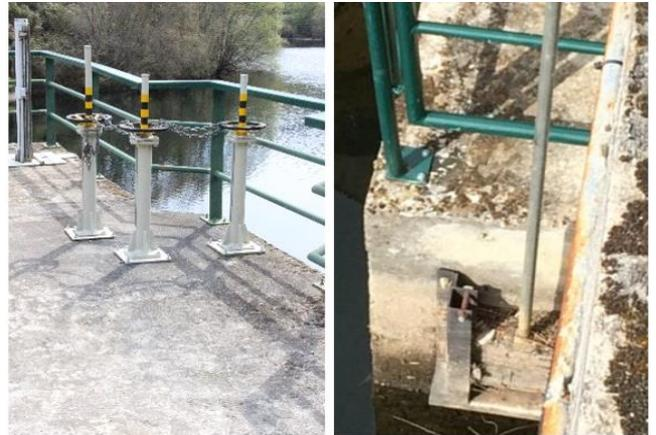
Figura 4. Comporta manual de regulação do caudal de alimentação: roldana manual para regular a posição da comporta (esq.) e comporta mural (dir.).
