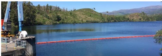
Figura 5. Grelha de retenção de detritos.
