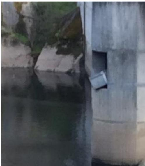
Figura 7. Desnível elevado entre a soleira da rampa de descarga dos peixes e o nível da albufeira.
