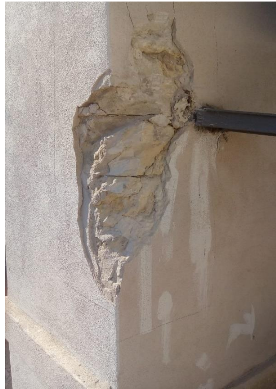
Figura 6. Stato della muratura ante intervento
