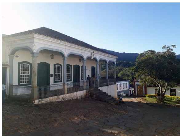
Figura 2. Vista atual da edificação voltada para a Rua da Câmara. Fonte: Acervo dos autores, 2022.
