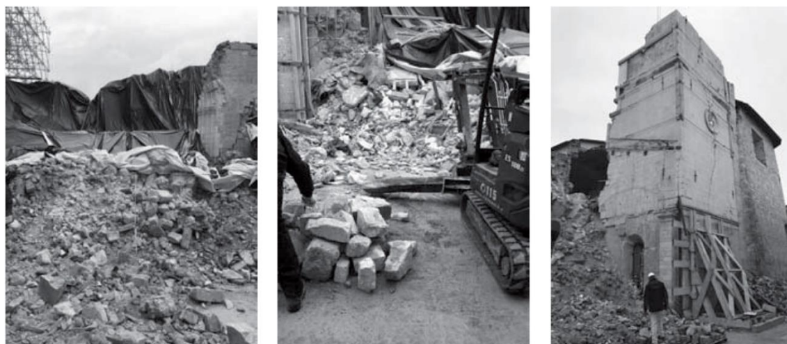
Figure 9-11. Norcia (PG). Chiesa di San Benedetto. Fasi di recupero e selezione delle macerie [45].
