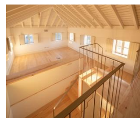
Figura 30. Sala reabilitada da construção anexa à Capela de N. Senhora da Conceição
