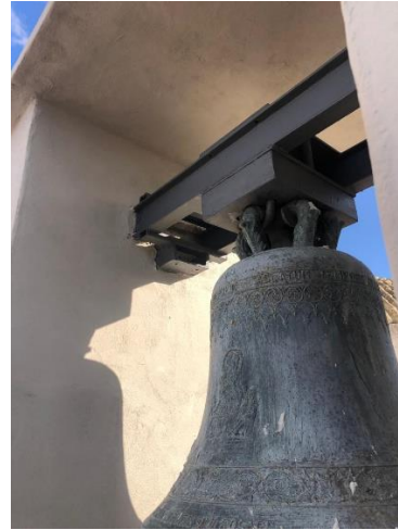
Figura 11. Dettaglio della muratura post intervento
