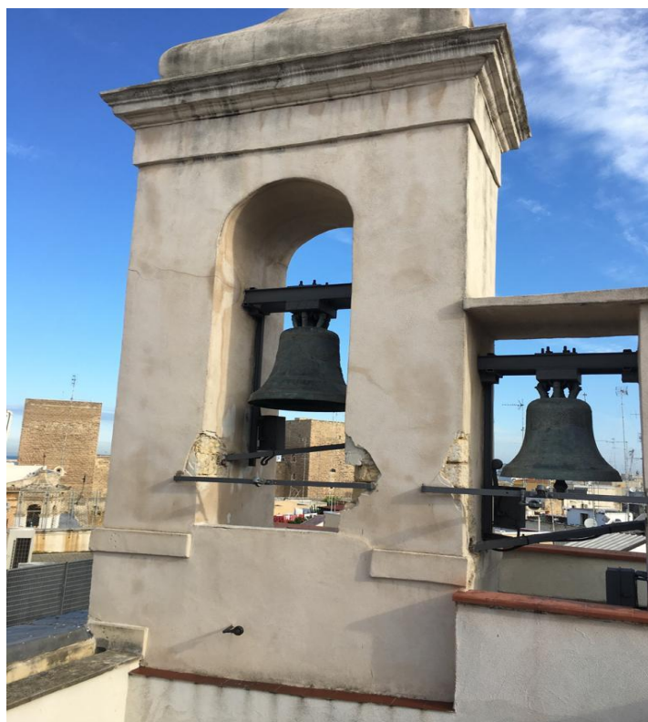
Figura 3. Campanile a vela ante dell'intervento
