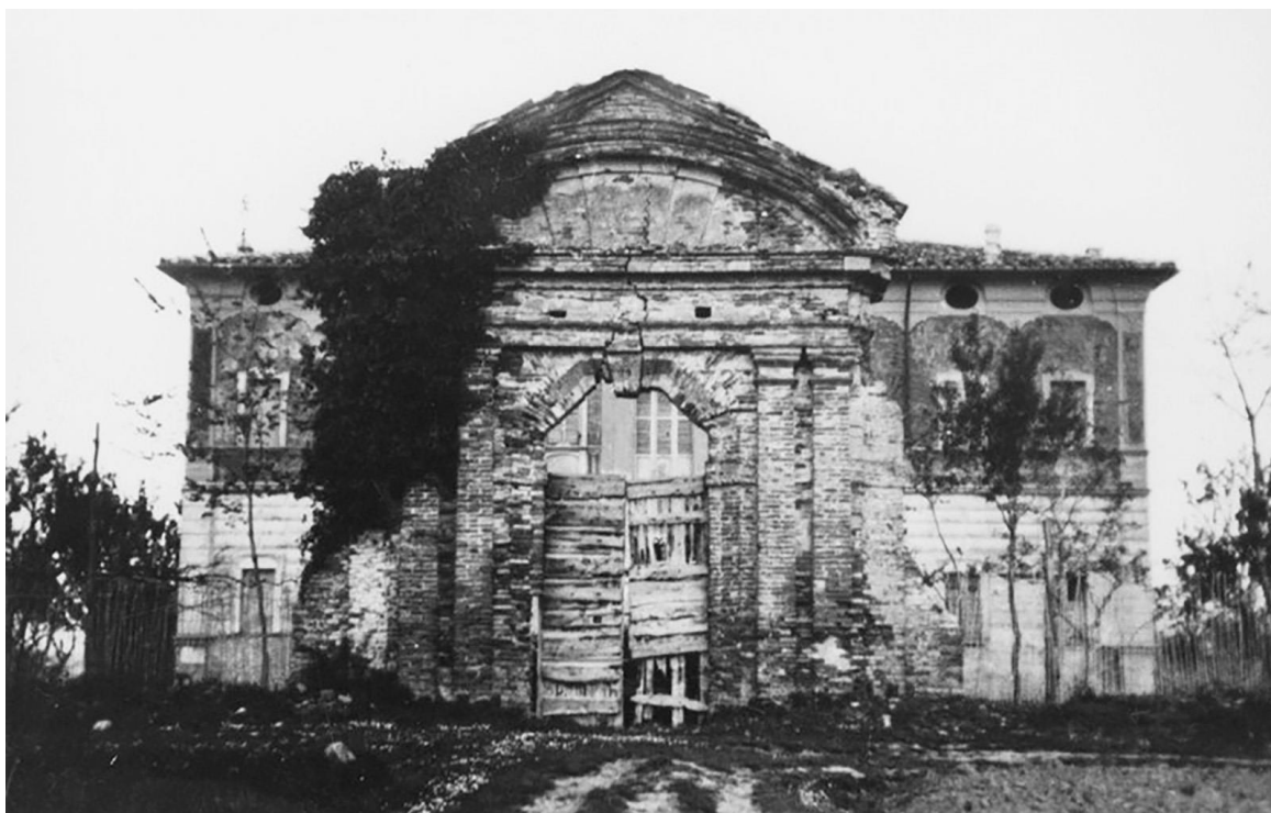
Figura 6. Portale di accesso a Scardavilla di Sopra, andato distrutto dopo il secondo evento bellico mondiale.
