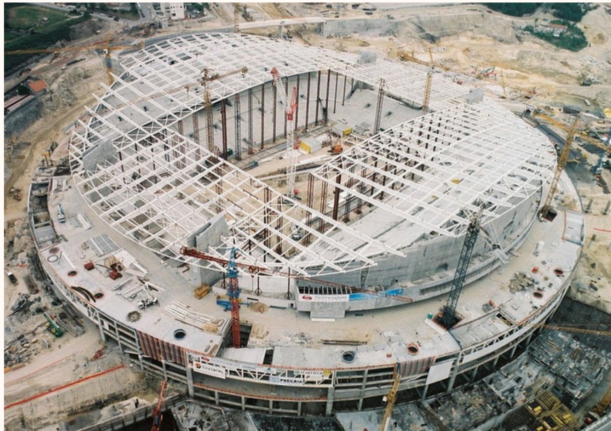
Figura 3- construção do Estádio do Dragão
