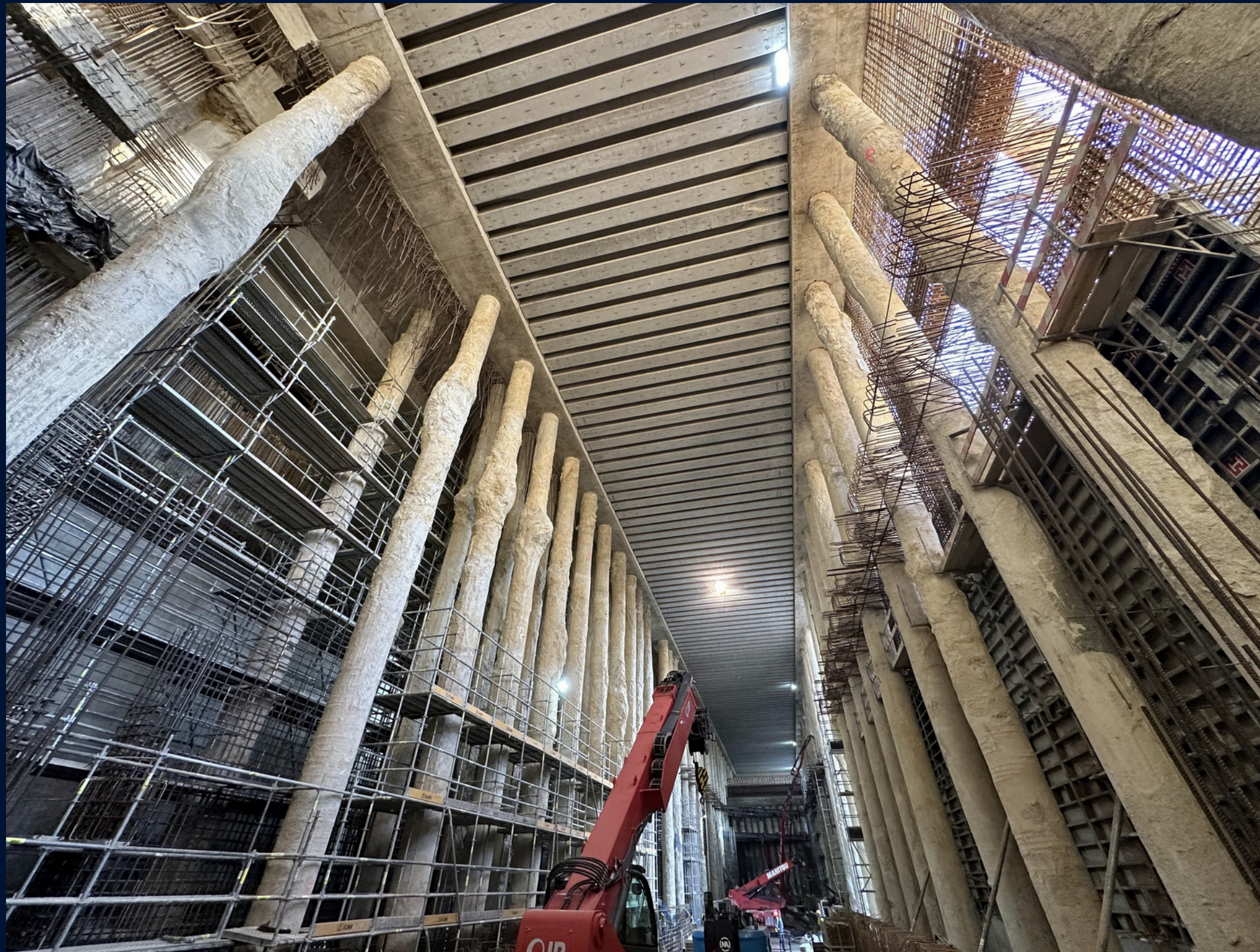
Figura 9. Pilares provisórios sob a Avenida de França
