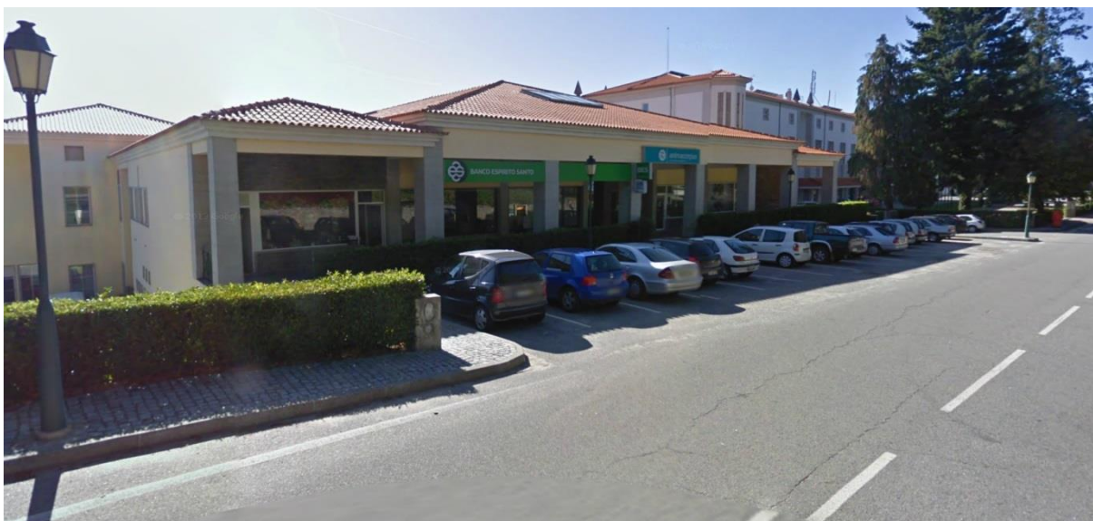
Figura 5.2 – Fachada do edifício do spa e do hotel do Caramulo
