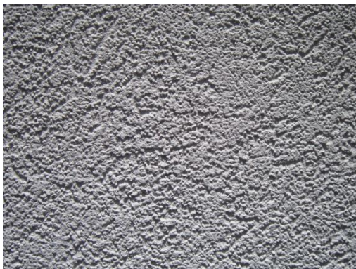
Figura 5.5 - Textura do Material Acabamento Exterior
