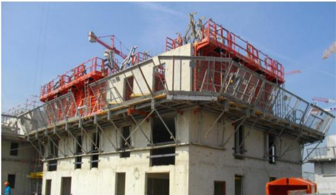
Figura 21 - Consolas de segurança para execução de paredes estruturais com recurso aos painéis de cofragem [13]
