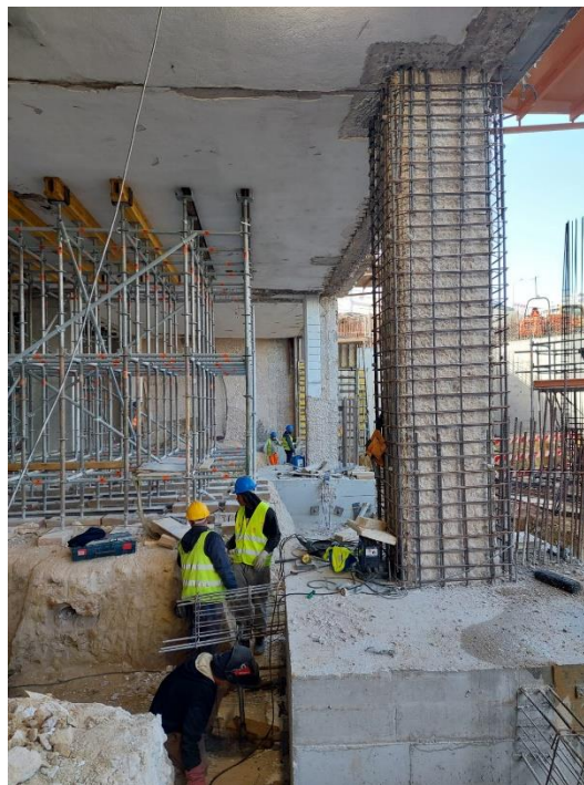
Figura 12. Fotografia de um pilar reforçado.
