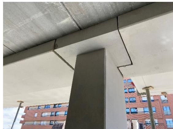
Figura 20. Consola curta oculta nos pisos de habitação.
