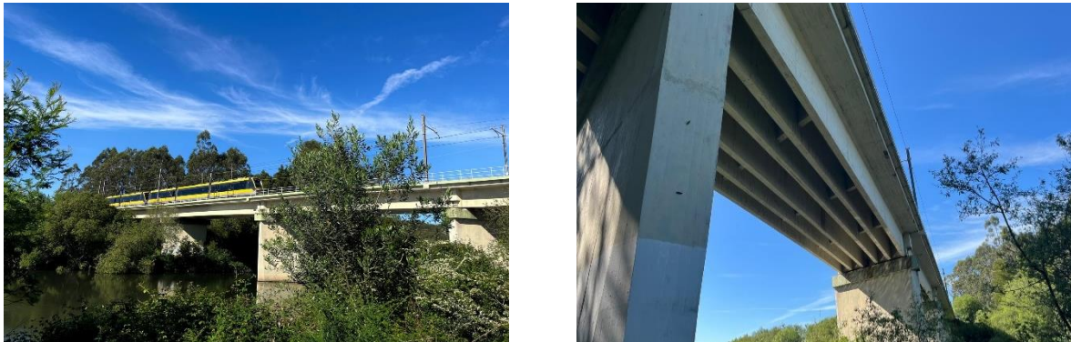
Figura 4. Vistas da ponte ferroviária sobre o Rio Ave.
