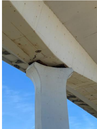
Figura 3. Geometria e ligação atual do Pilar ao tabuleiro.
