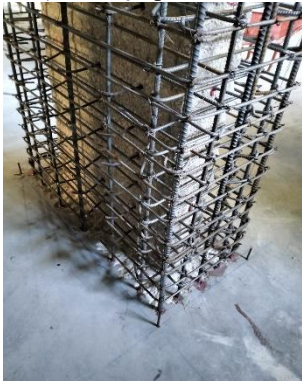
c) d) execução do encasamento de pilares
