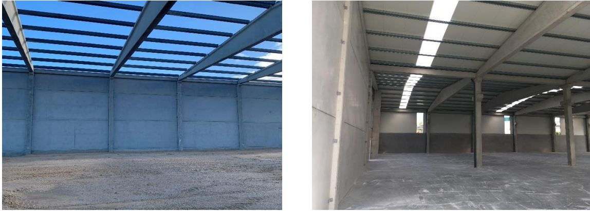
Figura 1. Edifícios industriais PFBA com painéis de fachada horizontais.
