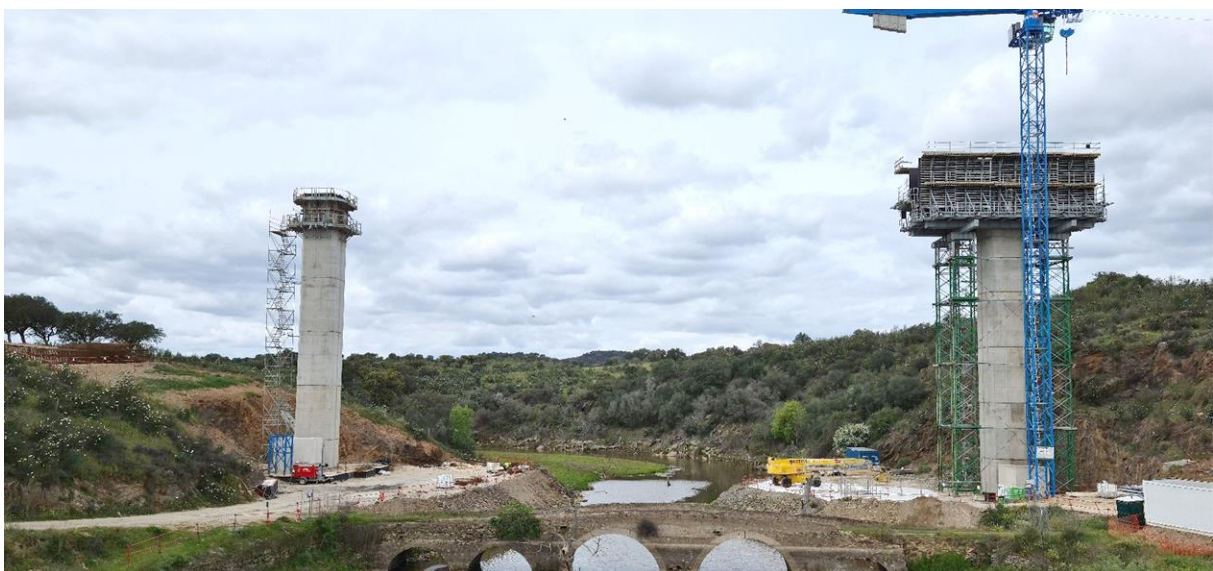
Figura 4. Processo Construtivo – Execução dos Pilares e Aduela de Arranque do Vão Central.
