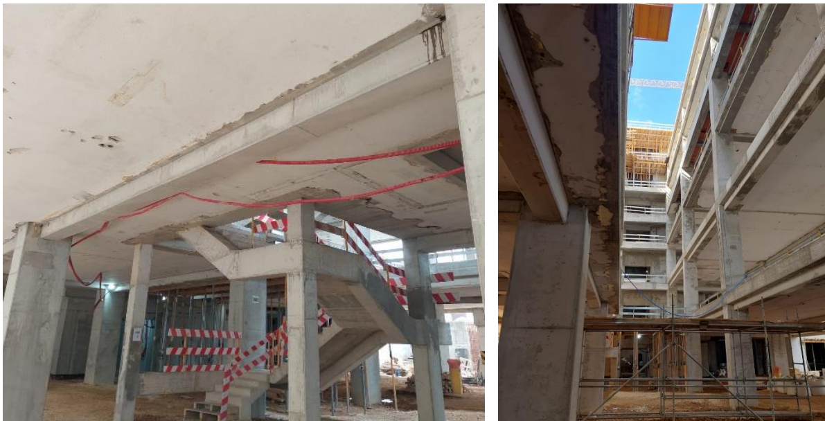
Figuras 9 e 10. Fotografias da obra das vigas de reforço.
