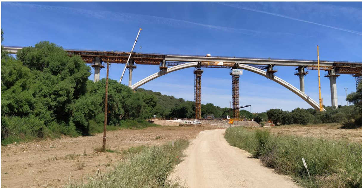
Figura 5. Processo Construtivo – Execução do tabuleiro sobre o Arco.
