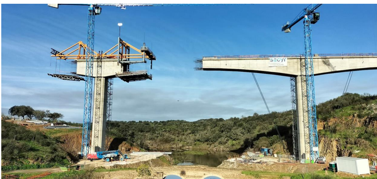
Figura 4. Processo Construtivo – Montagem dos Carros de Avanços do Lado Poente.
