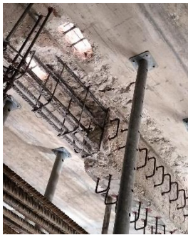
c) aspetos da execução do reforço das vigas
