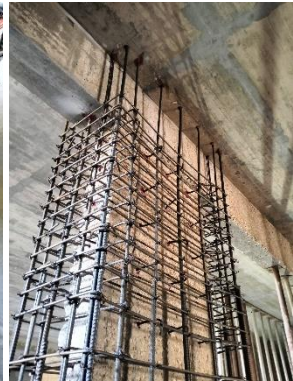
c) d) execução do encasamento de pilares
