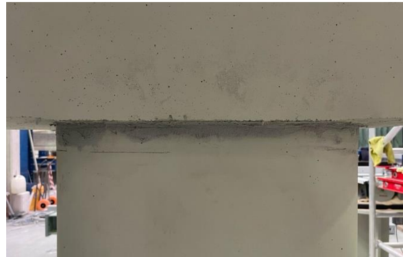
(b) após preenchimento com SikaDur-30.
