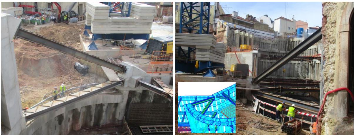
Figura 13. Escoramentos metálicos tridimensionais para restabelecer a continuidade do poço central.
