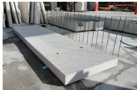
Figura 16. Laje maciça pré-fabricada para varanda em estaleiro.
