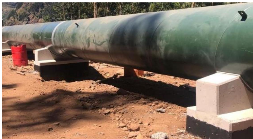
Figura 6. Berços em betão armado de suporte da conduta metálica DN1200.
