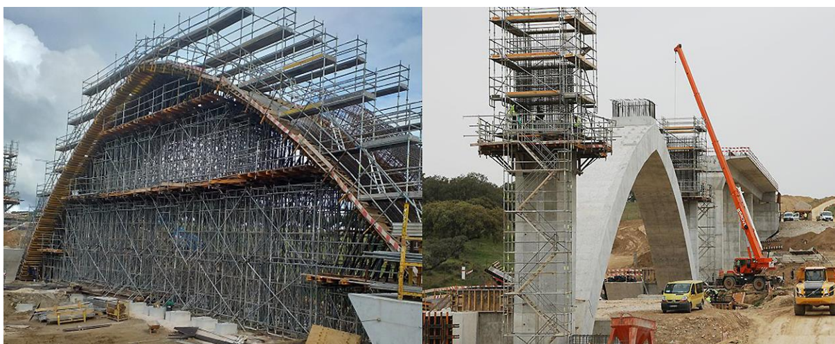
Figura 6. Viaduto do Barranco dos Pegões – Cimbre e Cofragem para Execução dos Arcos e Pilares.
