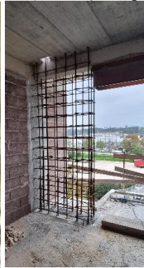
Figura 11. Reforço dos pilares por encasamento de betão e adição de paredes.
