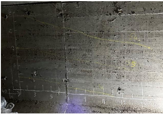
Figura 3. Fotografia da superfície ensaiada com marcação da posição dos cabos.
