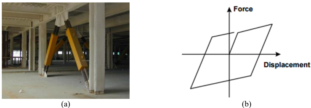
Figura 2. Amortecedor metálico: (a) BRB instalado (b) Curva histerética de um BRB.
