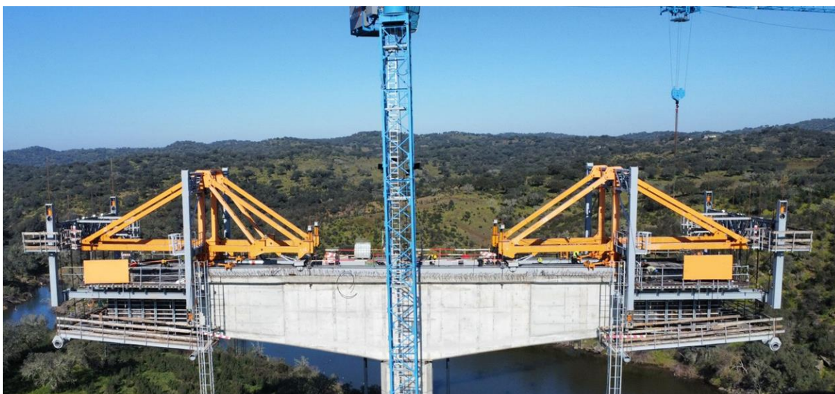
Figura 4. Processo Construtivo – Pormenor dos Carros de Avanço.
