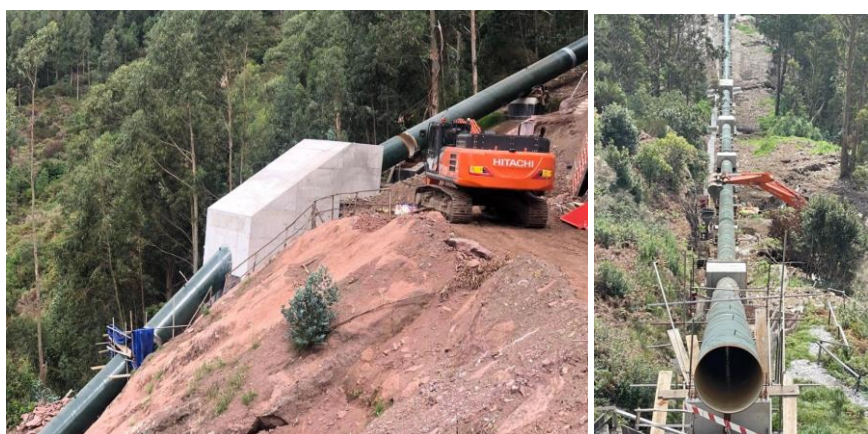
Figura 5. Maciços de amarração em betão armado e montagem da conduta DN1200.
