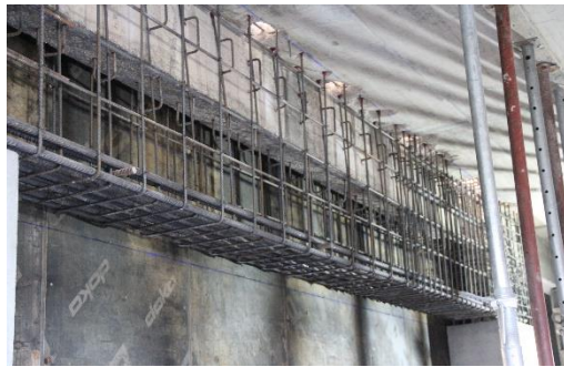
c) aspetos da execução do reforço das vigas
