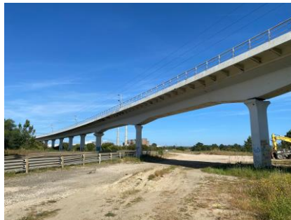
Figura 1. Viaduto Ferroviário de Sines.
