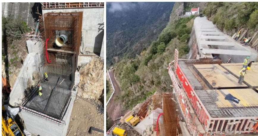
Figura 4. Construção da nova estrutura da câmara de carga (à esquerda) e câmara de acumulação (à direita, ao fundo) com vigas de travamento no topo.
