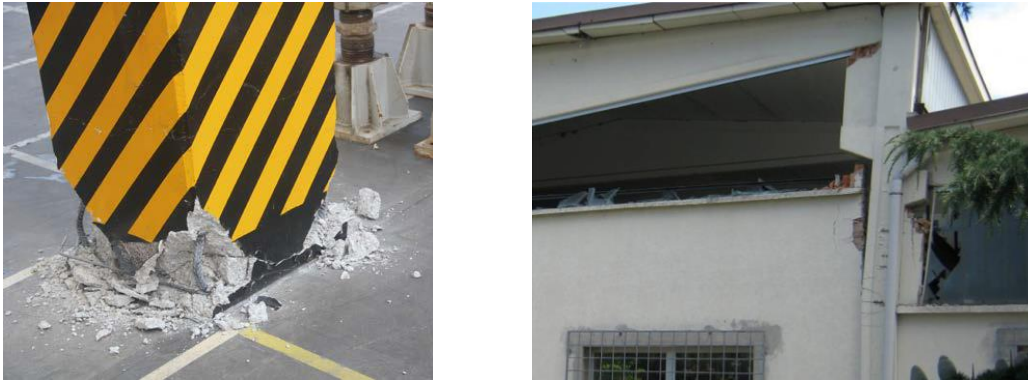
Figura 3. Rotura da base do pilar (Esquerda) [8]; Falha de um pilar curto (Direita)[9].
