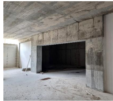
e) imagem de viga e pilares de apoio após reforço
