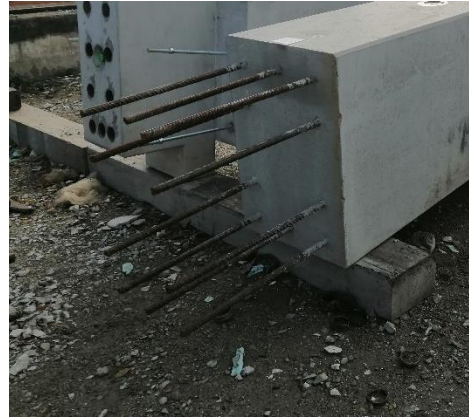
Figura 18. Varões em espera na face inferior do pilar pré-fabricado para ligação à fundação/continuidade entre pilares
