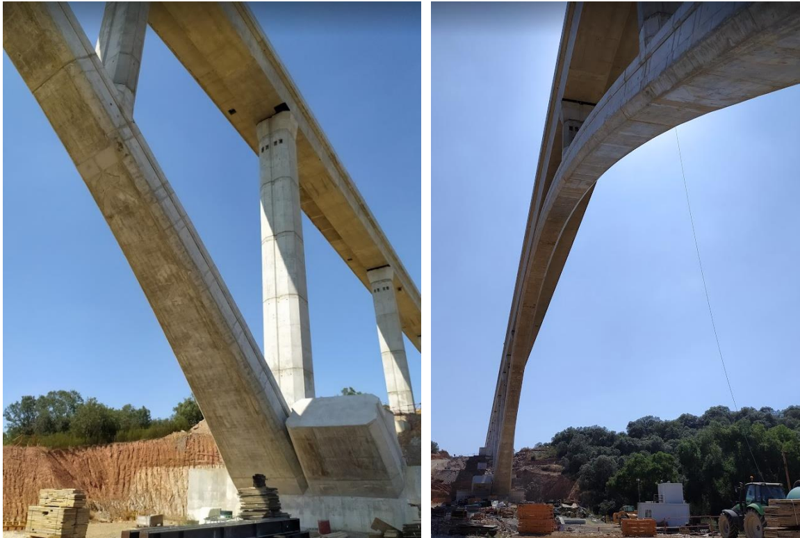
Figura 6. Perspetiva da Obra – Zona do Arco.
