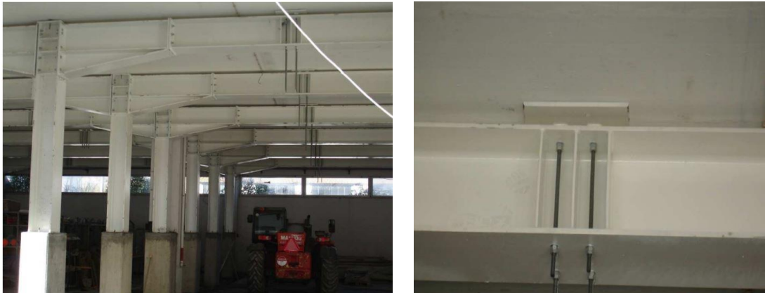
Figura 2. Reforço e Reparação do Edifício dos Bombeiros Voluntários da Trafaria - Vista geral e pormenor do sistema de aplicação do pós-esforço [5].
