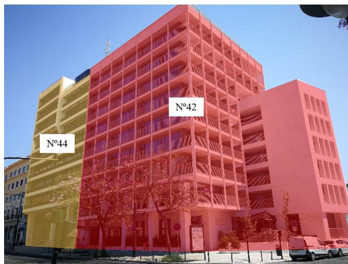
Figura 1. Edifícios de betão armado situados por cima do túnel.
