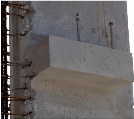
Figura 21. Ferrolhos numa consola curta em pilar.
