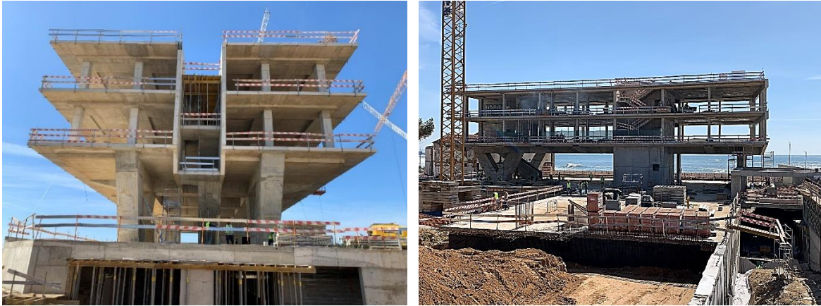
Figura 11. Edifício em fase de obra com a estrutura finalizada.
