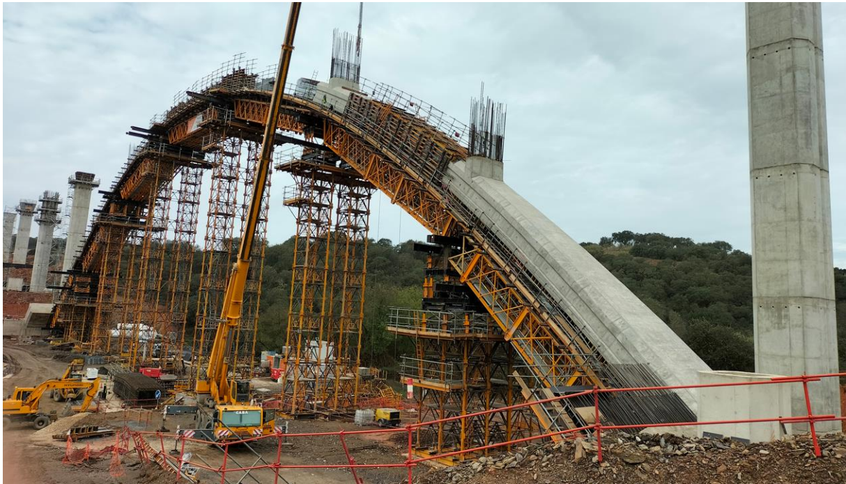
Figura 4. Processo Construtivo – Execução do Arco.
