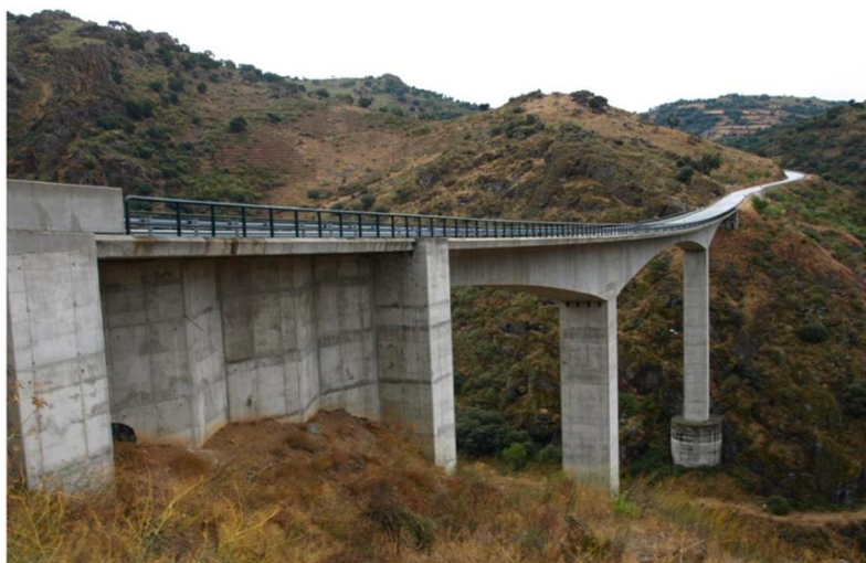
Figura 6. Ponte sobre o Rio Angueira.
