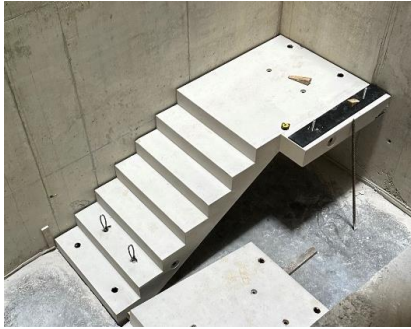
Figura 13. Elemento de escada em obra.
