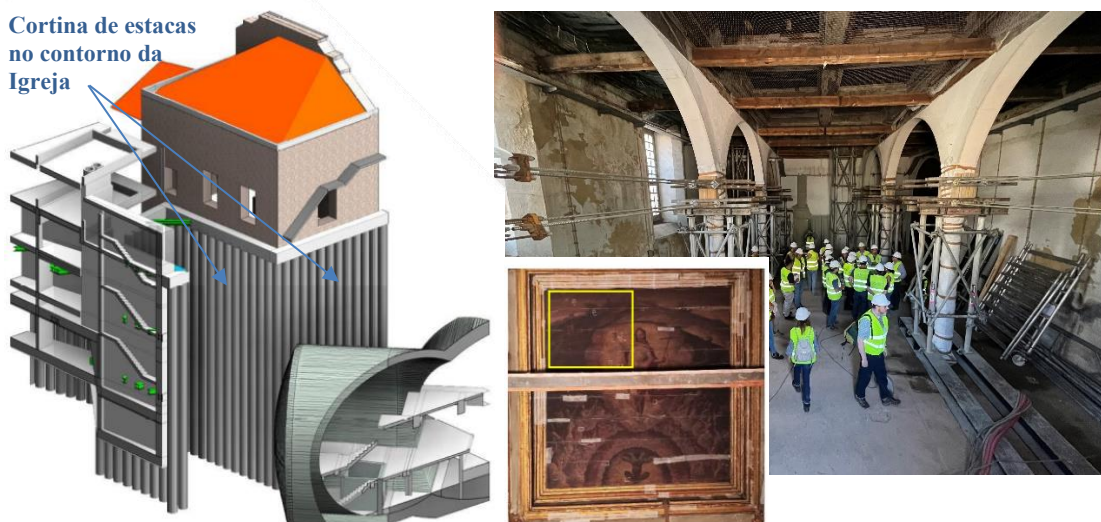
Figura 5. Antigo coro da Igreja: cortina de estacas “barreira”, atirantamento dos arcos e painéis originais pintados em talha dourada encontrados sob o tecto falso existente.
