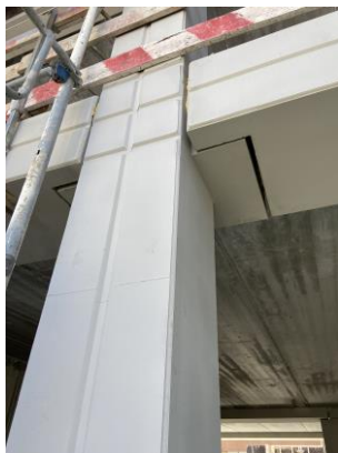
Figura 6. Pilar de fachada.
