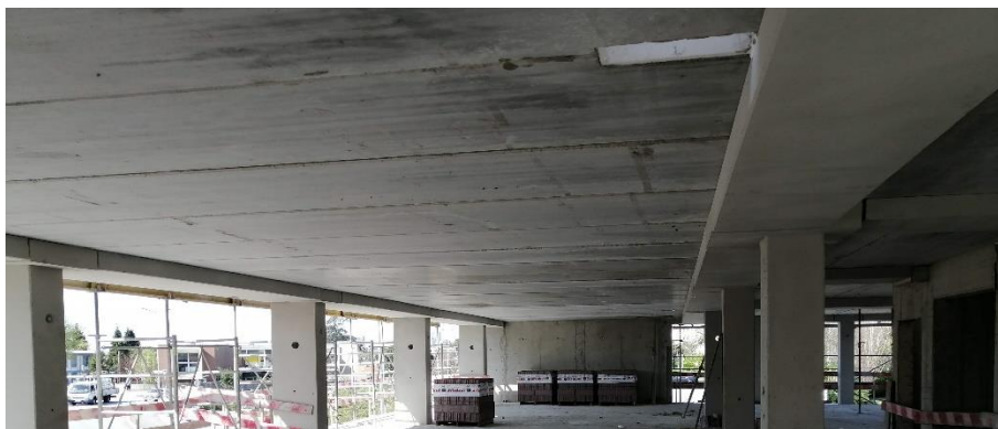
Figura 12. Vista da estrutura do teto de um piso tipo.
