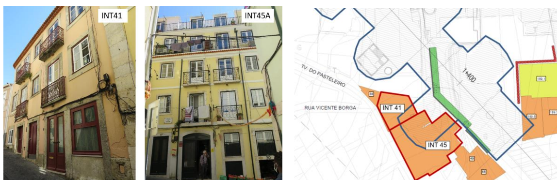
Figura 1. Edifícios a recalçar: Vista frontal (à esquerda) e localização em planta (à direita).
