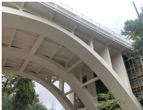
Figura 10. Estrutura dos arcos laterais.
