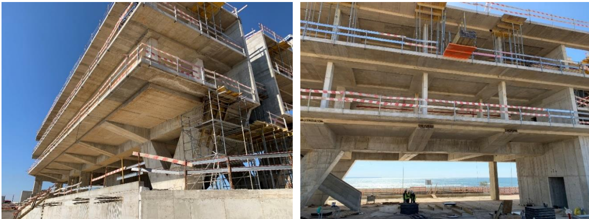
Figura 12. Edifício em fase de obra com a estrutura finalizada.
