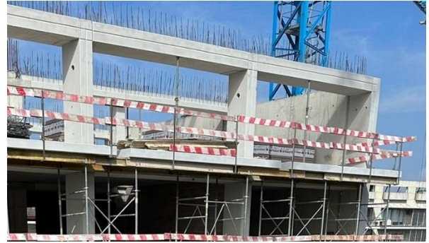
Figura 10. Viga montada em obra.
