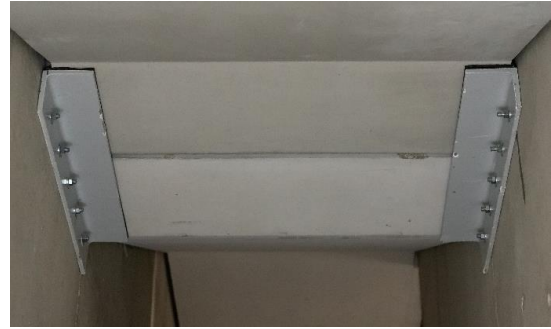
Figura 14. Apoio das escadas nas paredes do núcleo.
