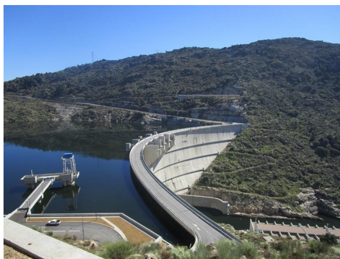
Figura 1. Barragem do Baixo Sabor (vista da margem direita).
