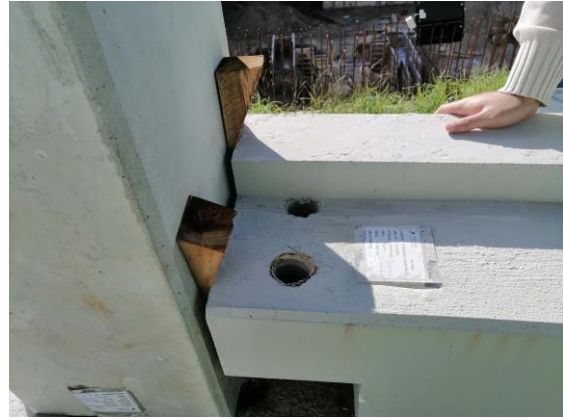
Figura 22. Bainhas corrugadas na viga.
