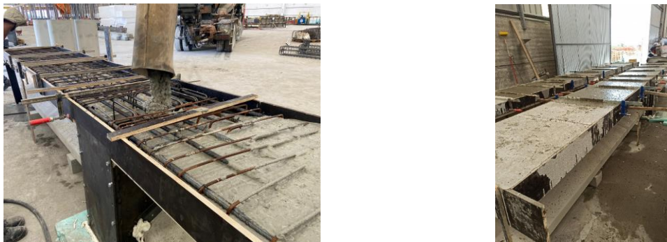
Figura 3. 2ª fase de betonagem (C-F-1) e 3ª fase de betonagem (C-F-2)
