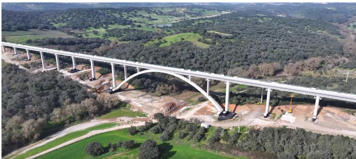
Figura 8. Perspetiva Geral da Obra Acabada.
