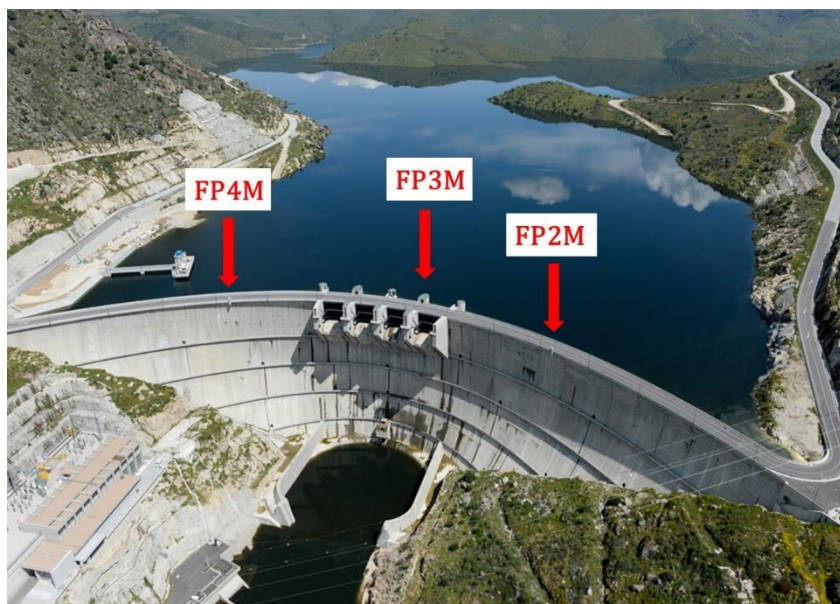
Figura 2. Localização das estações GNSS na Barragem do Baixo Sabor: FP2M, FP3M e FP4M no coroamento.
