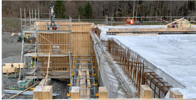
Figura 12. Ponte Raunesteinsli – Nichos das ancoragens de pré-esforço – implementação em obra.
