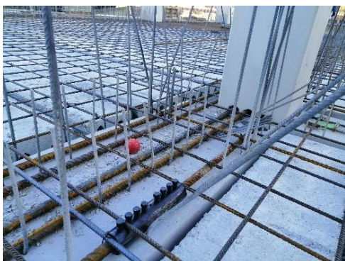
Figura 24. Armadura de cintagem a atravessar um pilar e acopladores da armadura de cintagem.
