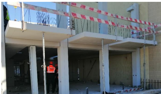
Figura 15. Elemento de viga com varanda embutida em obra.
