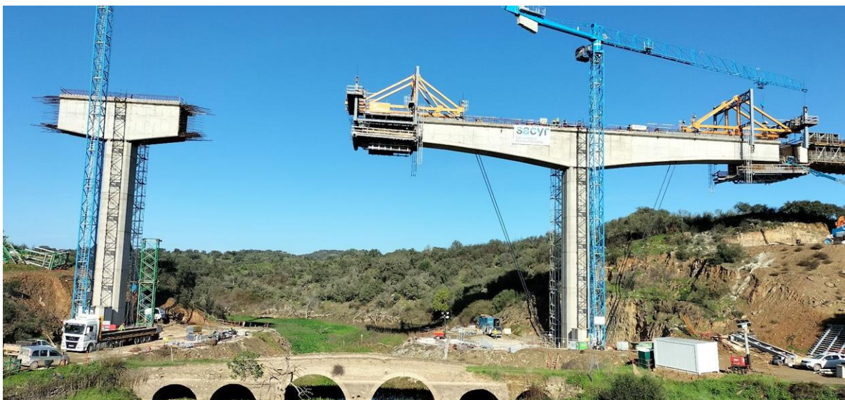
Figura 4. Processo Construtivo – Execução do Tabuleiro Nascente do Vão Central por Avanços Sucessivos.
