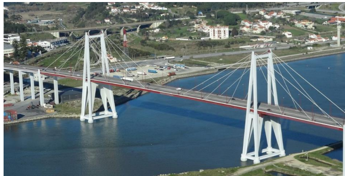
Figura 1. Vista geral da ponte Edgar Cardoso, na Figueira da Foz.
