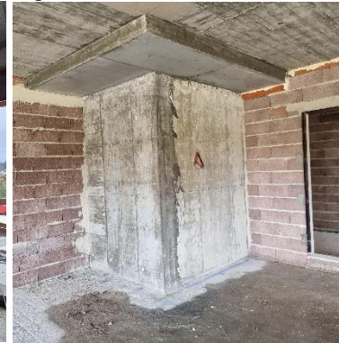
f) parede interior e capitel adicionados
