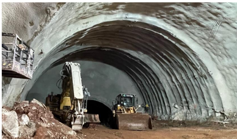
Figura 7. Escavação Subterrânea – Conclusão da escavação da calote superior.
