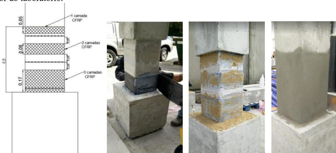
Figura 2. Processo de reparação e reforço com esquema das cintas em metros.
