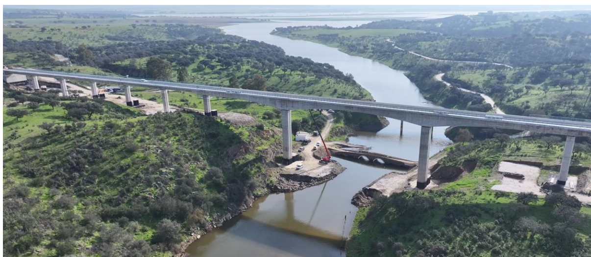
Figura 6. Perspetiva da Obra – Zona do Vão Central sobre a Ribeira da Asseca.
